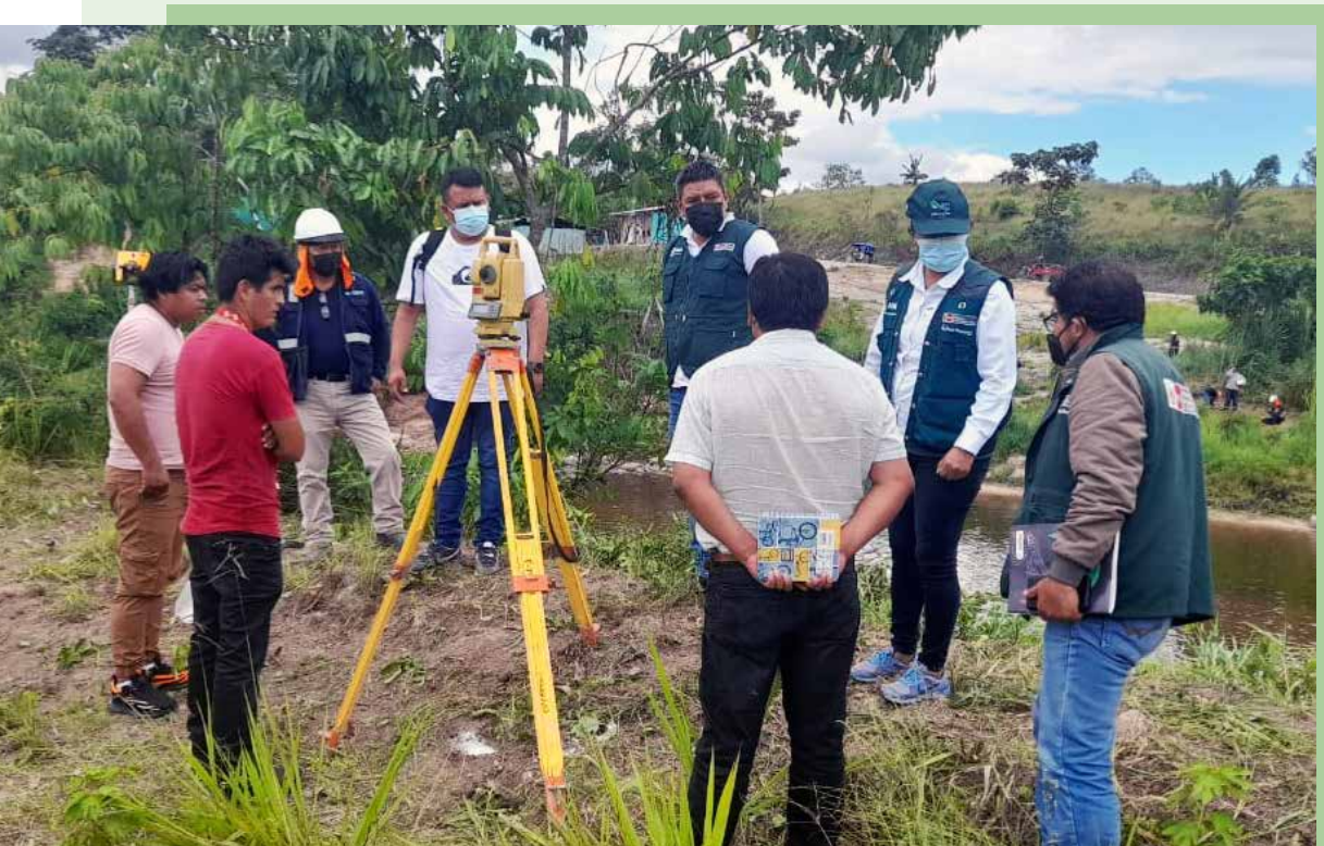
Inicio de obras civiles de la EHA Naranjillo con participación de las autoridades de la CCNN Awajun de Huascayacu
