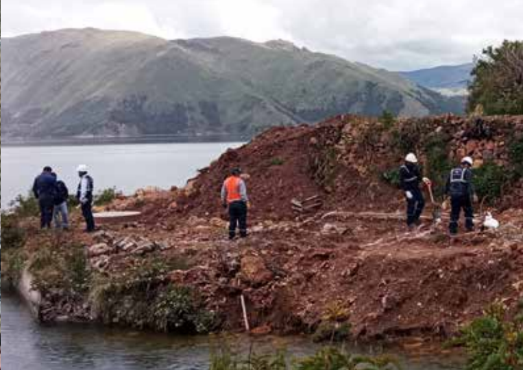
Construccion de EHA Laguna Pomacanchi
